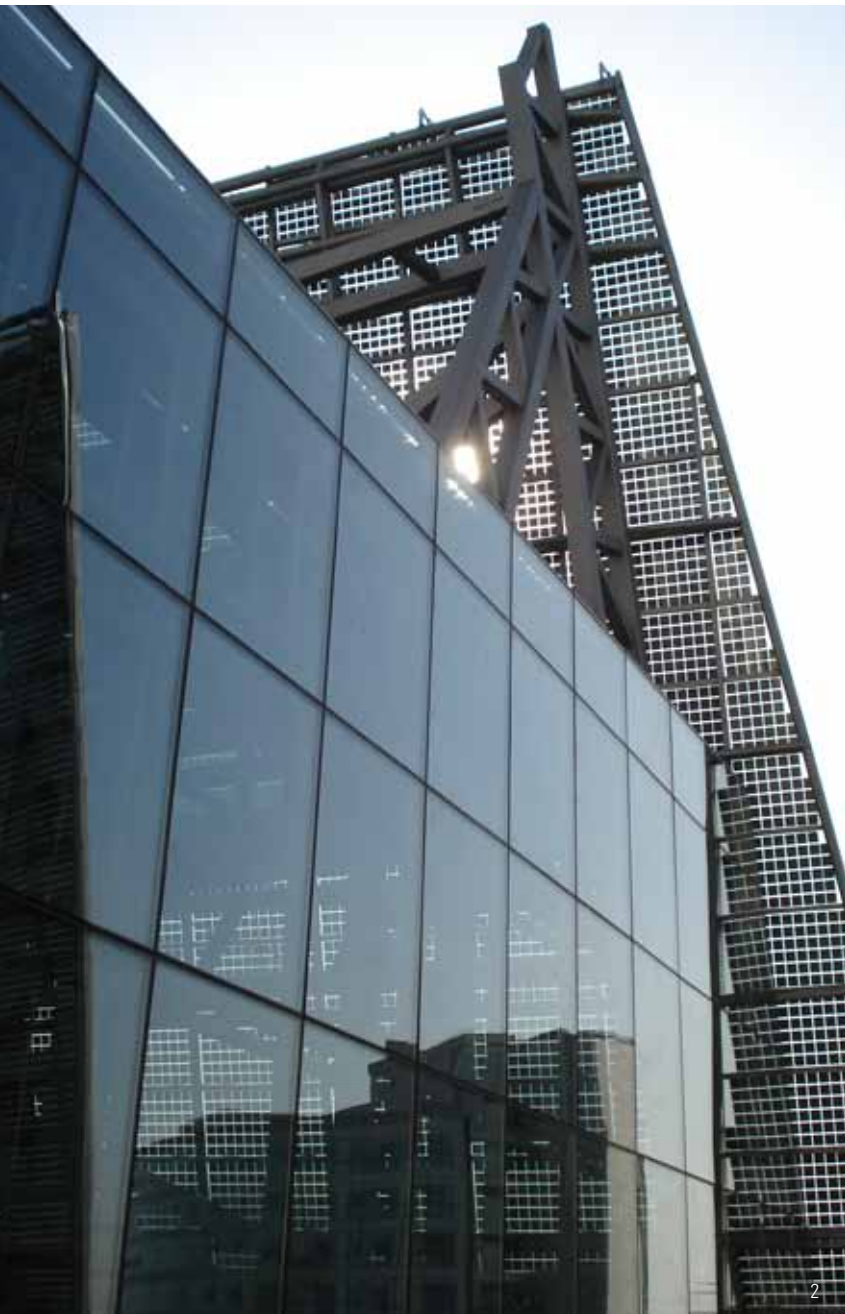
图2: 办公大楼和康乐中心外的玻璃外壳(图片提供: 尚德电力)
